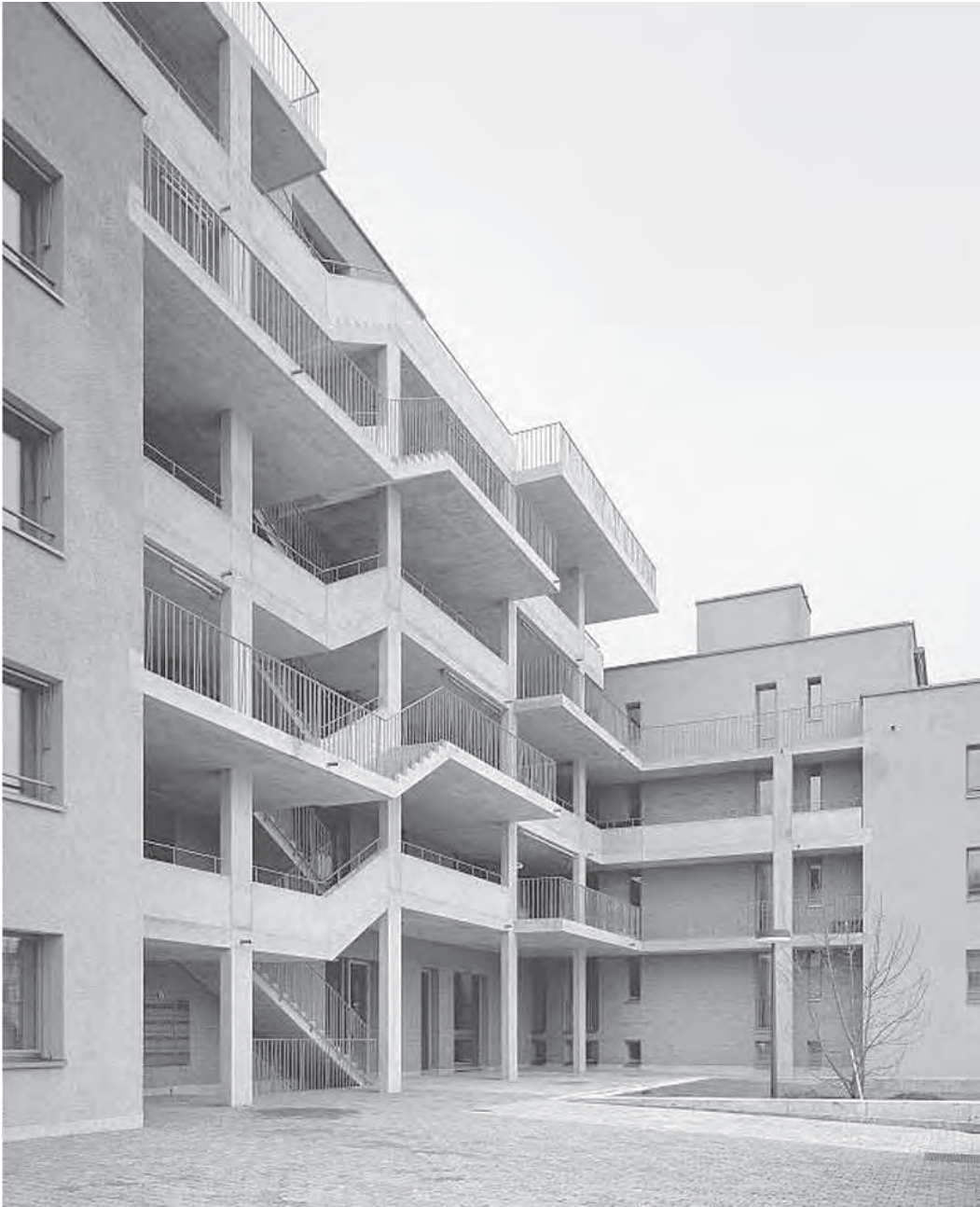
maitre d'ouvrage : BAUGENOSSENSCHAFT KRAFTWERK1
