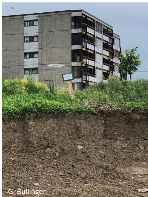
Stockage des matériaux terreux aux abords du chantier
