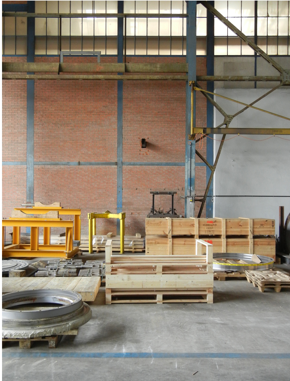
Halle 7 - Bâtiment existant
